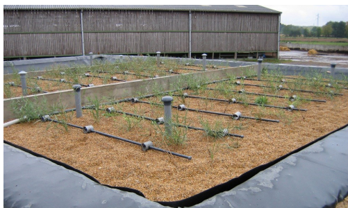
Filtres à sable plantés de roseaux © Tanguy Morel
