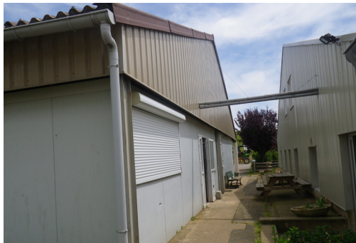
Exemple de transfert de lait jusqu'en salle de fabrication : le lactoduc
