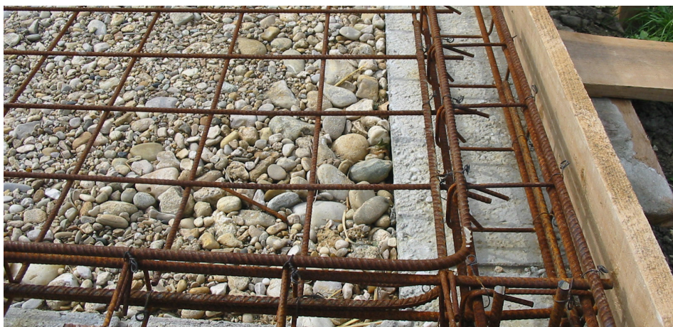
Préparation d'une dalle en béton
