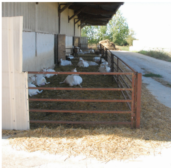
Un exemple d'aire bétonnée couverte (= avec un toit)
