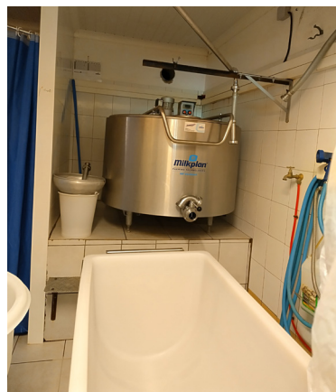
LE COMPRESSEUR DU TANK APORTE DE LA CHALEUR QUAND IL EST SITUÉ DANS LA LAITERIE
